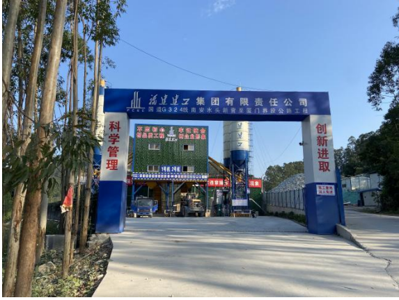
项目西北侧：福建建工集团有限责任公司南安分公司拌合站
